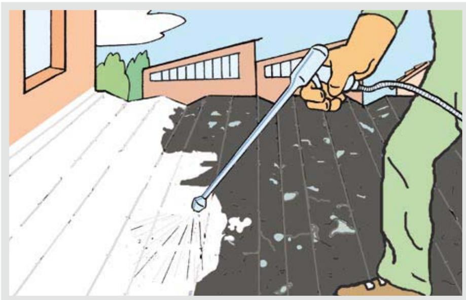
**Oripplast** è un rivestimento per esterno formulato con speciali resine sintetiche a base acquosa. Applicato su una vecchia membrana ossidata la re-impermeabilizza e protegge dall'invecchiamento provocato dagli agenti atmosferici. Se fosse necessario applicare su guaina bituminosa non ossidata, procedere primerizzando la superficie con primer a solvente (tipo Eposint®).
